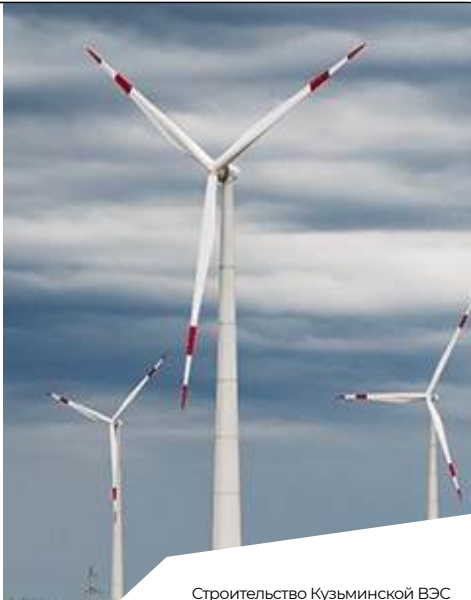
Строительство Кузьминской ВЭС (АО «ВетроОГК-2»)
